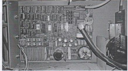
14. Отсутствует блок питания дверного механизма на кабине лифта
