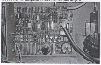
12. Отсутствует блок питания дверного механизма на кабине лифта
