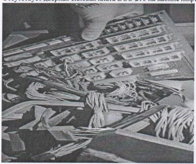
11. Отсутствует дверная плата на кабине лифта
