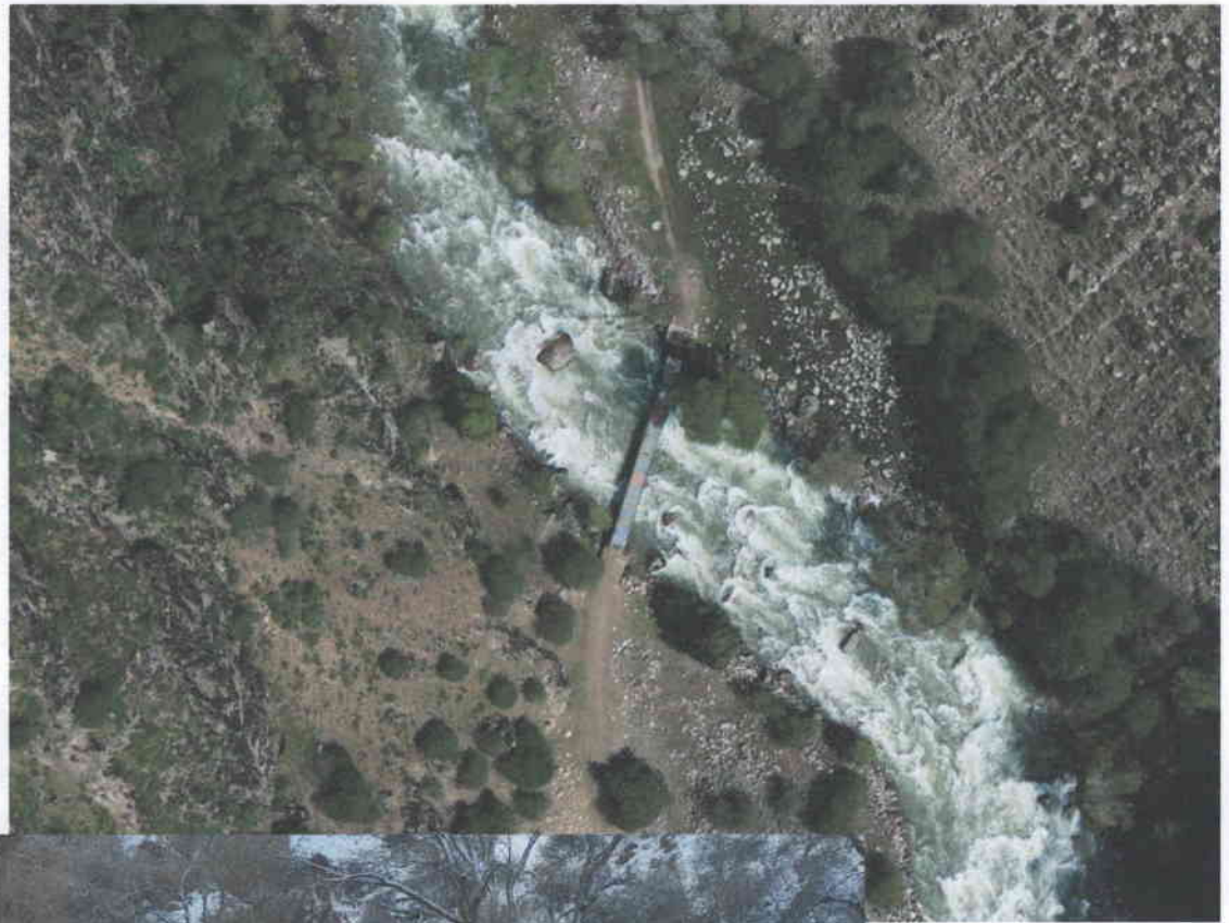
Мост через реку Ахангаран
